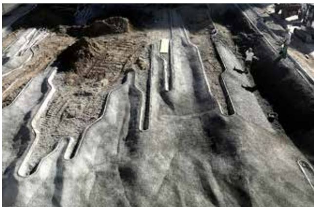
Vue du chantier de L'enfance du pli , sculpture-paysage © Gilles Brusset
