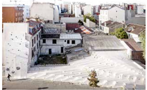
TRANCHES DE VILLE Contreplaqué extérieur + madriers - Clichy-la-Garenne - 2014 - © Pierre-Yves Brunaud
